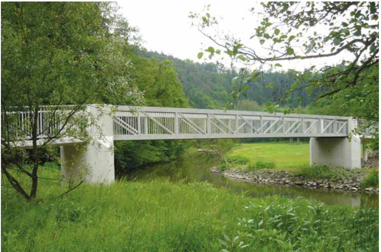
Trinkwasser Hochbehälter (oben); Aluminium Fertigteilbrücke über die Wied (unten)
